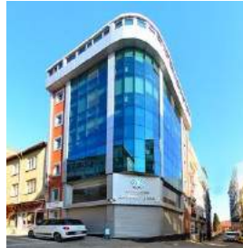
Kolordu Ek Hizmet Binası
