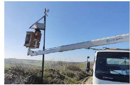
Kaçak moloz döküm alanlarına güneş enerjili, merkezden kontrol edilebilen kamera sistemi kurulumları
