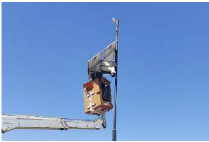
Kaçak moloz döküm alanlarına güneş enerjili, merkezden kontrol edilebilen kamera sistemi kurulumları
