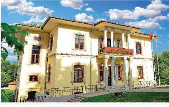
Tarihi Bina: Ortacami Mahallesi Hükümet Caddesi No:14
