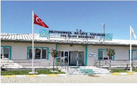
Fen İşleri Müdürlüğü Ek Hizmet Binası: Karadeniz Mahallesi Trabzon Caddesi No:23/3
