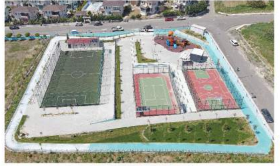
Şehit Fırat Yılmaz Çakıroğlu Spor Tesisleri: Atatürk Mah. Çandarlızade İbrahim Paşa Cad. 265. Sok No:04
