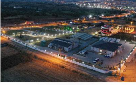
Zabita ve Afet İşleri Müdürlükleri Ek Hizmet Binası : Altınova Mah. Çevre Yolu Cad. No:64-64/1
