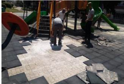
Çınarlı Mahallesi Şerife Bacı Parkı
