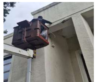
Ajans Binası Elektrik Tadilatı
