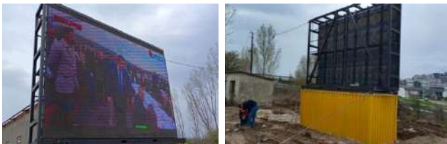
Değirmenaltı Mahallesi Led ekran kurulumu
