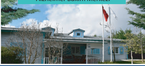
Altınova Mahallesi Alzheimer Bakım Merkezi
