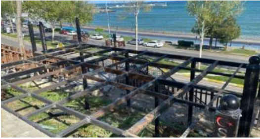
Tuna Boyu Seyir Terası Yapımı
