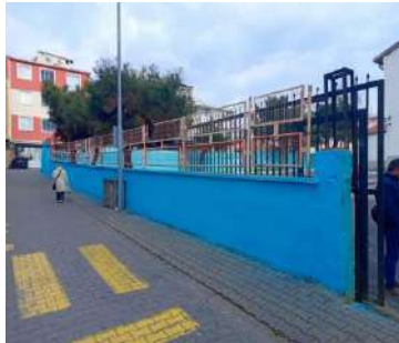
Okul Duvarı Boyama çalışması
