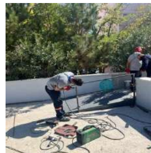
Sahil Çiçek Parkı ve Nihat Sami Banarlı ortaokulu engelli rampası yapıldı. Direklerle altı engelli tuvaletleri için rampa yapıldı.
